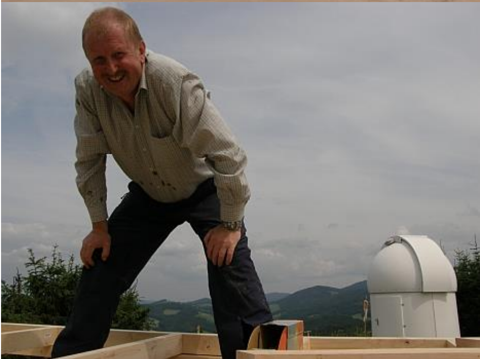
Das Grundgerüst für den Holzunterbau wurde angefertigt.
