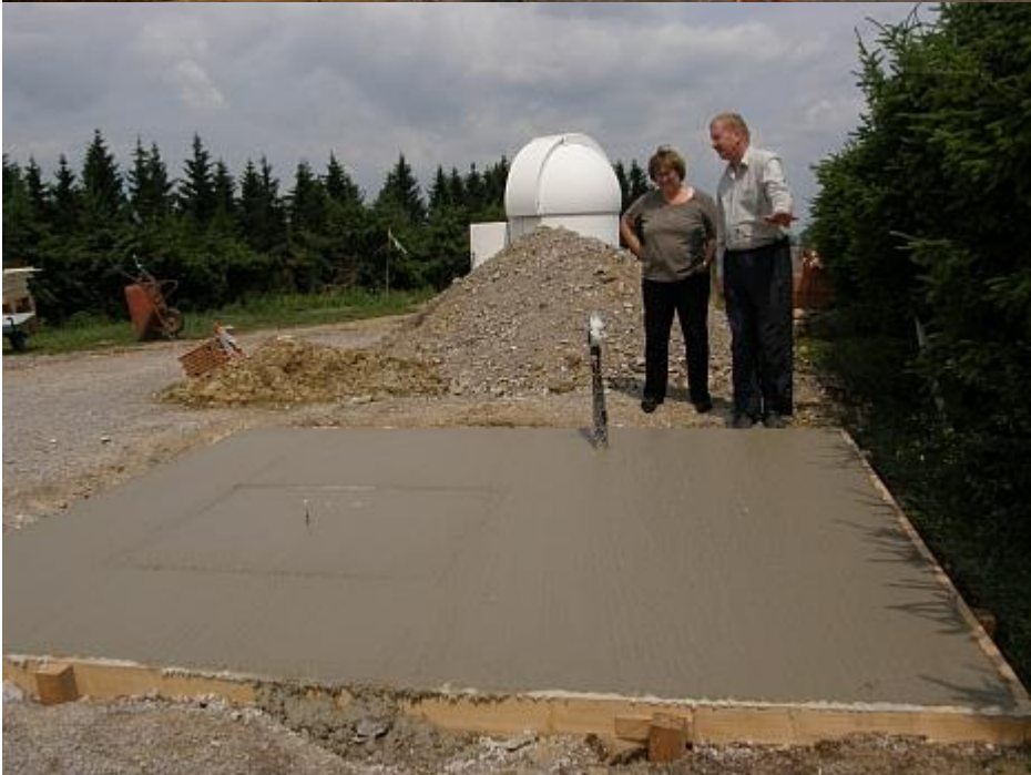
Der Beton für das Grundfundament wurde angeliefert und aufgetragen.
