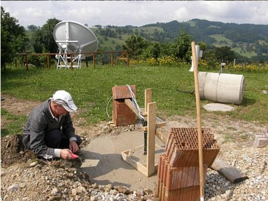
Auch die Außensäule bekommt ein neues Fundament.
