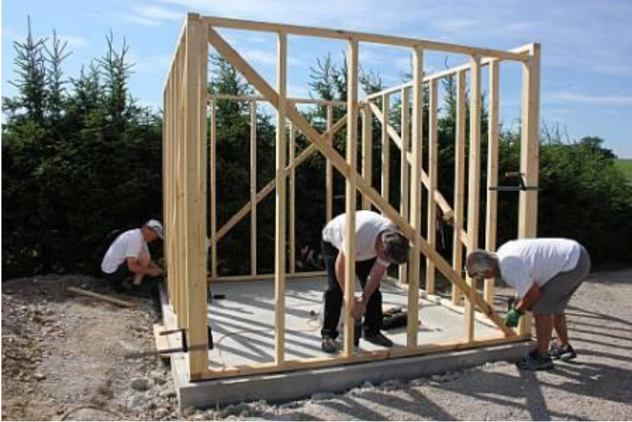
Das Grundgerüst für den Unterbau des AST war schnell aufgestellt.
