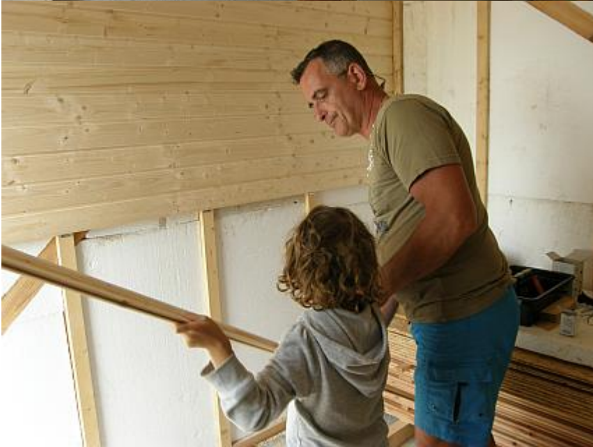
Die Außenwände wurden gestrichen und im Innenbereich das Styropor angebracht
