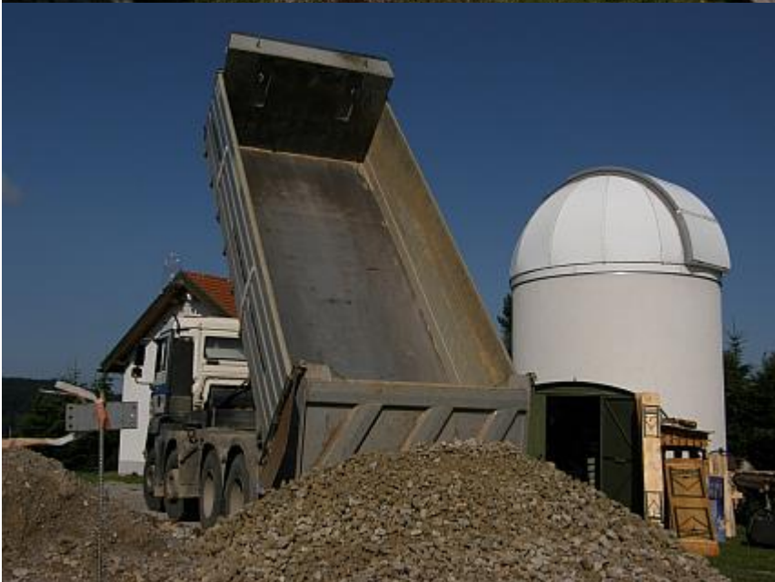
Material für Fundament wurde gebracht
