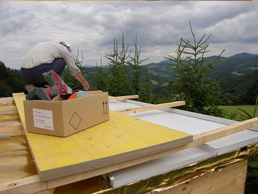
Das Dach wurde isoliert und die Verblechung angebracht
