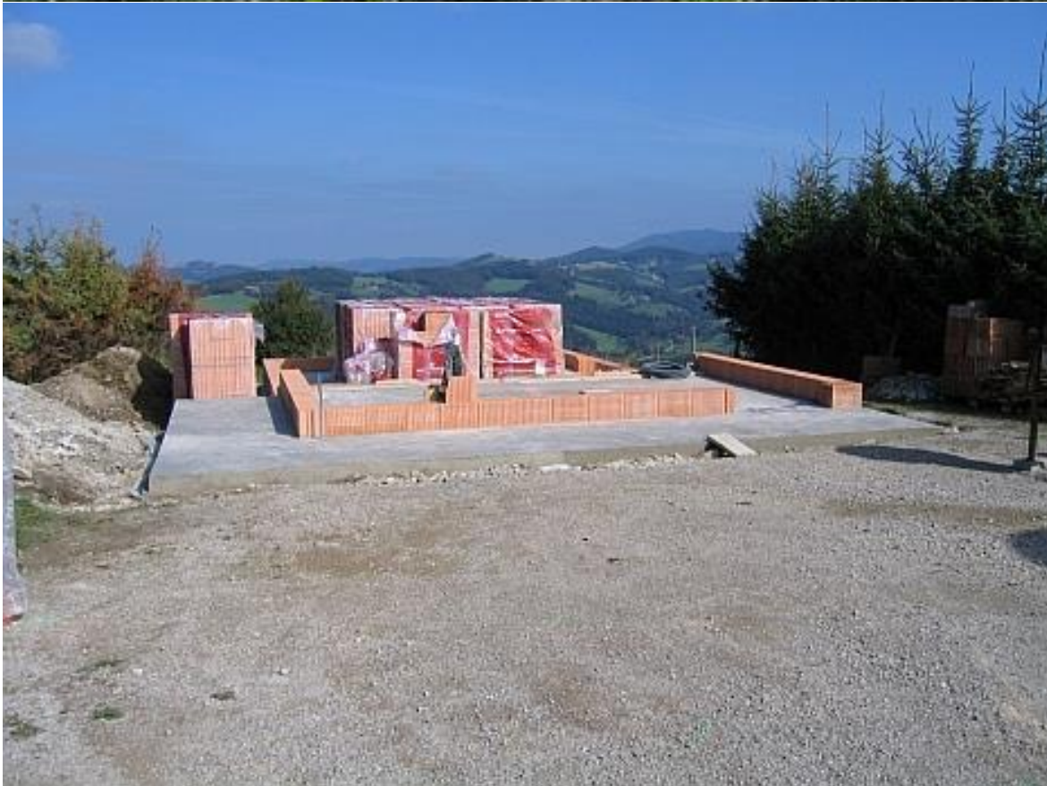
Baustahlgitter und Grundfundament
