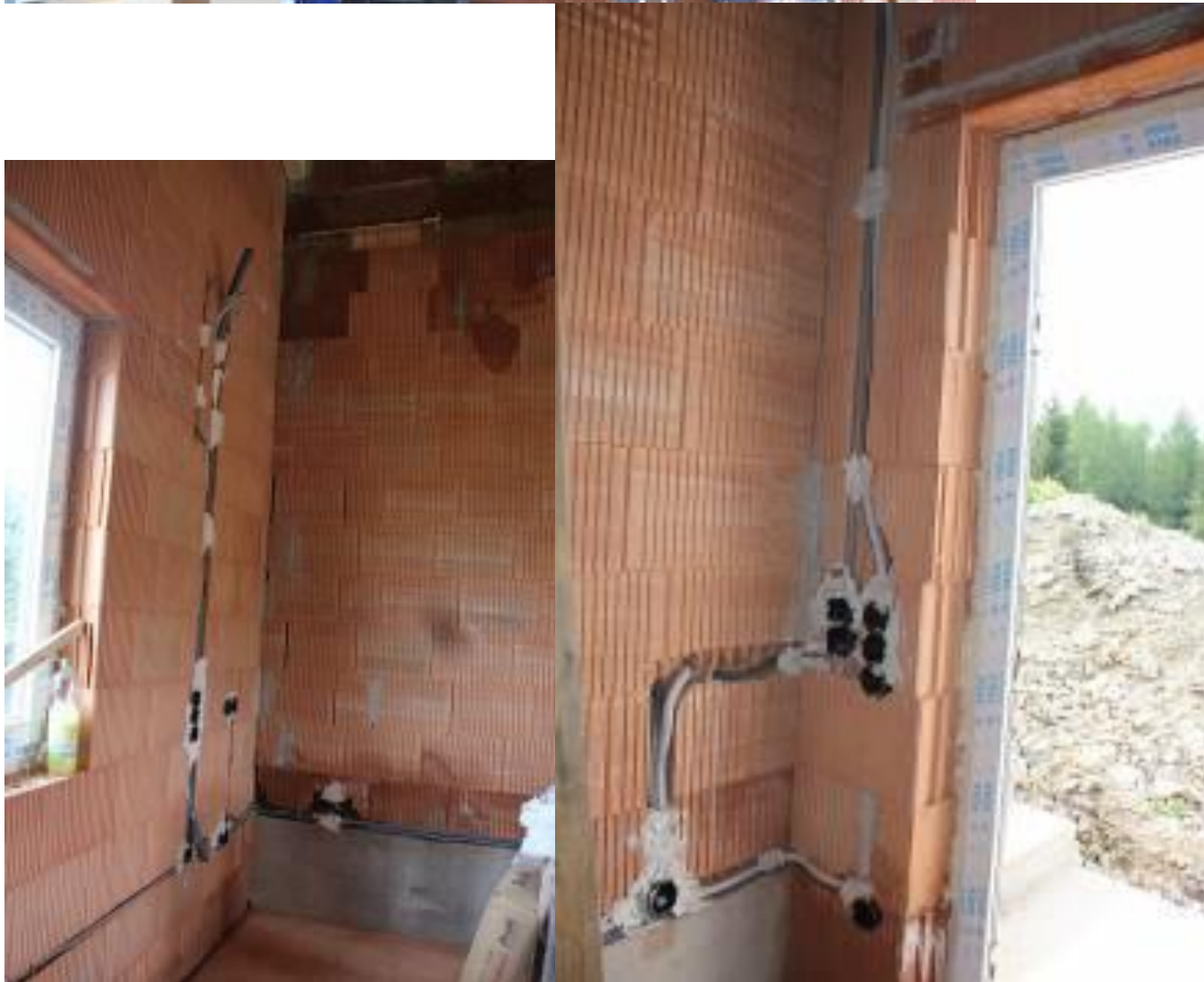
Die Stromleitungen für den Experimentalraum innen und außen werden gelegt.
