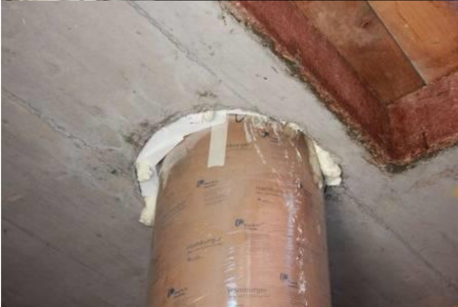
Die Säule für das Sonnenobservatorium wurde bereits mit Beton gefüllt.
