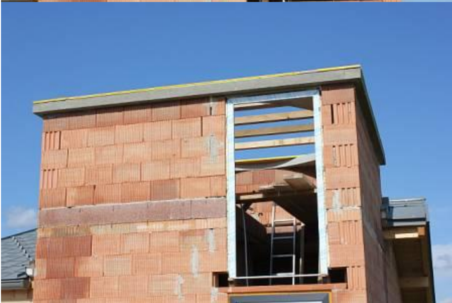
Der Betonring für die Kuppel ist bereits zu sehen und der Türstock zum Sonnenobservatorium eingebaut.
