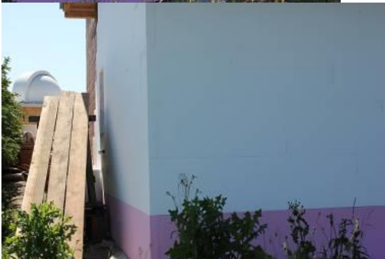
7. Juni - an der nördlichen Wand wird weitergearbeitet
