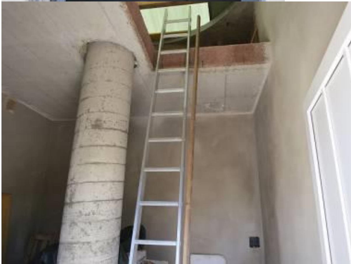
Die Innenräume sind bereits verputzt.
