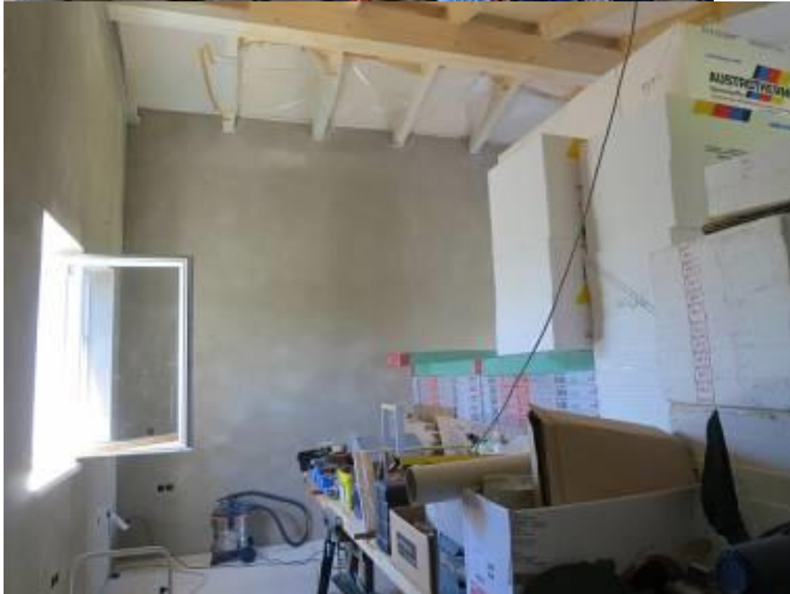
Viel Baumaterial lagert derzeit im neuen Experimentalraum.
