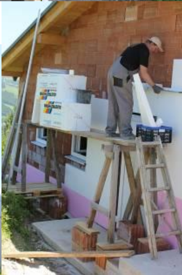
Auf der nördlichen Seite ist die Gerüstkonstruktion etwas waghalsig.
