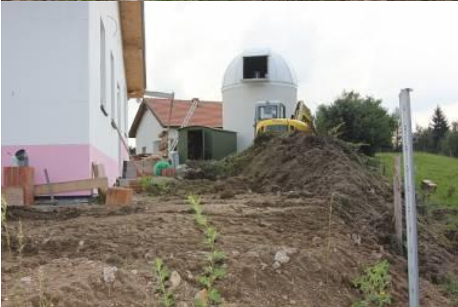
19. Juli - Begradigen des Parkplatzes und Versetzen des grünen Containers
