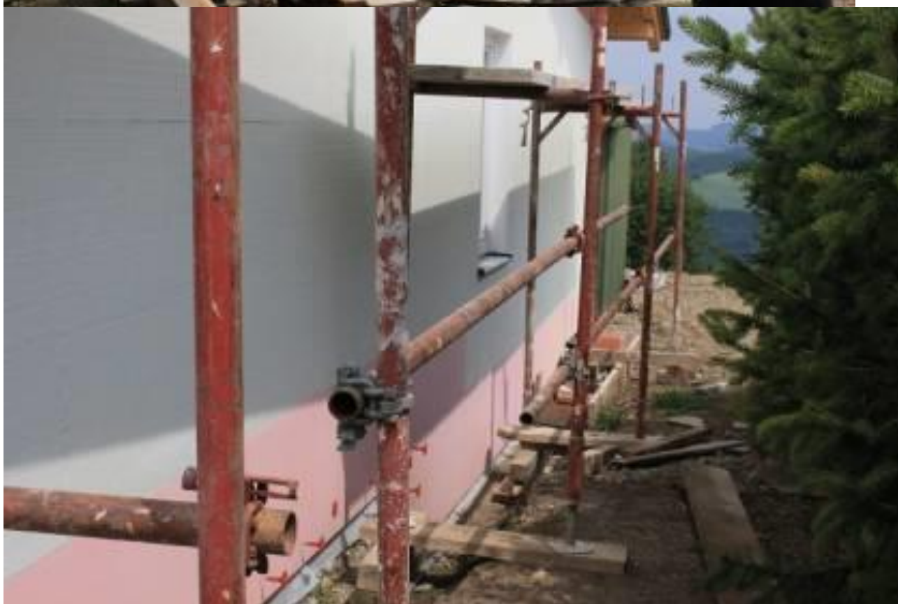
Das Gerüst für die Außenfassade.
