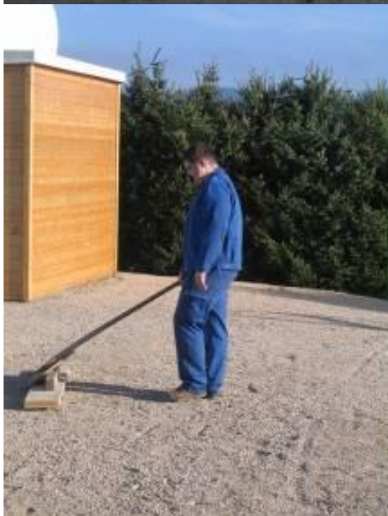
Der gesamte Fahrbereich wurde begradigt und neu geschottert.
