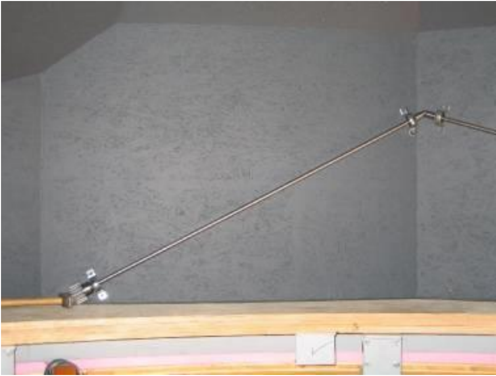
Ein Teil der Synchronsteuerung der Schieber
