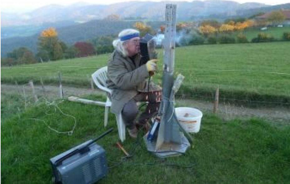
Fritz Lensch beim Schweißen der Halterung für den 6m hohen Mast auf den die e-Callisto Antenne montiert wird.
