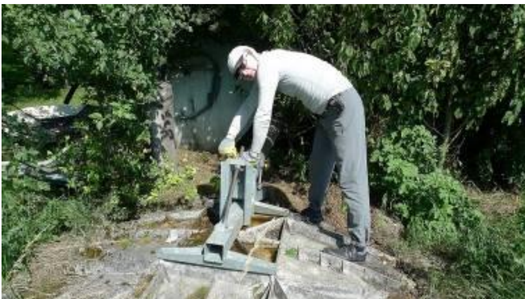
Fritz Lensch beim Schweißen der Halterung für den 6m hohen Mast auf den die e-Callisto Antenne montiert wird.
